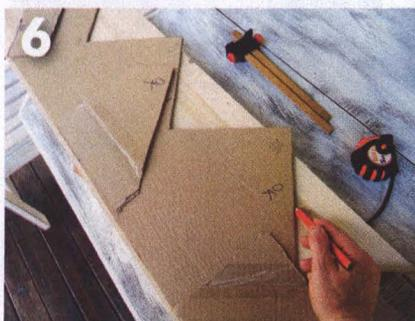
На заготовки для косоуров нанесли разметку по картонным шаблонам. Поскольку досок нужной ширины для изготовления косоуров найти не удалось, к имеющимся доскам решили приклеить накладки.
