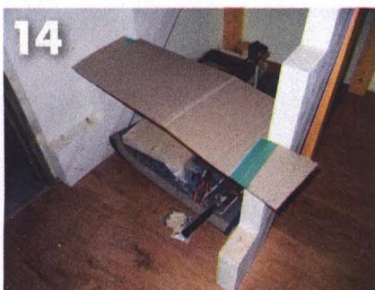
**14** Шаблоны для ступеней, выкроенные в соответствии с проектом лестницы, примерили и подогнали по месту...
