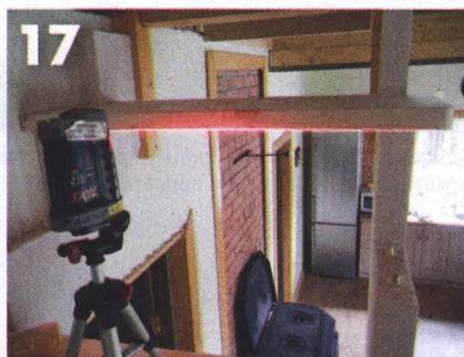
**17** Перед окраской и монтажом горизонтальность каждой ступени проверяли лазерным уровнем.
