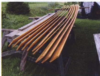
бруски под досками подшивки боковых свесов, уложили на них этот базовый элемент шипом вверх и по месту отметили на нём участки, которые нужно отпилить.
