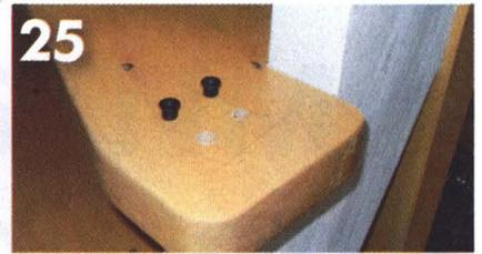
25 Для установки поручня в ступени и опорном столбе просверлили по разметке отверстия под шканты.
