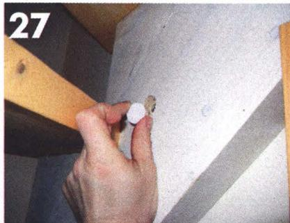
27 Технологические крепёжные отверстия заглушили окрашенными деревянными пробками.
