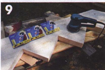
Поверхности подготовленных косоуров тщательно обрабатывали шкуркой разной зернистости с помощью орбитальной шлифовальной машинки.
