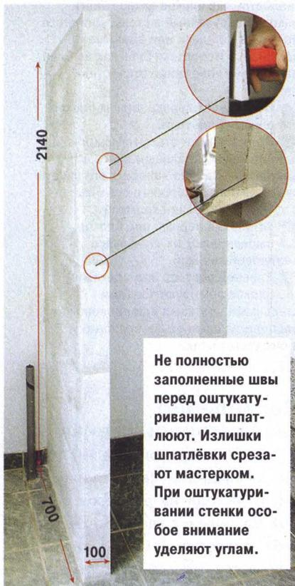
Не полностью заполненные швы перед оштукатуриванием шпательюют. Излишки шпательювки срезают мастерком. При оштукатуривании стенки особое внимание уделяют углам.
