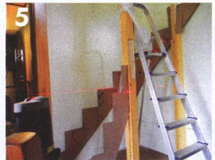
**5** Выставив шаблоны, проверили их взаимное положение лазерным уровнем.
