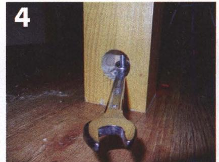
**4** Опорный столб прикрепили к полу с помощью резьбовой сантехнической шпильки, предварительно просверлив под неё отверстия в столбе.
