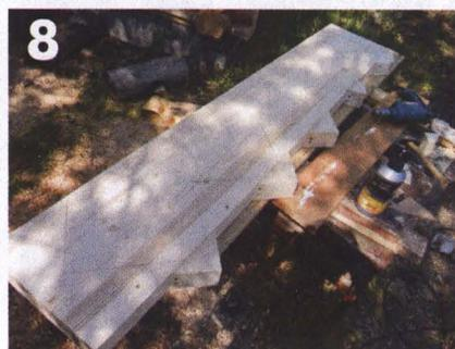
... на клею ПВА и шкантах временно притягивая накладки саморезами к заготовке для косоура.
