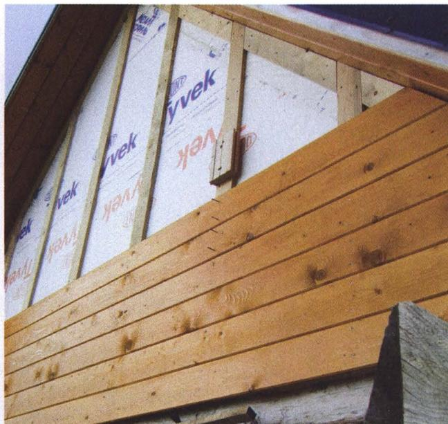
Элементы обшивки крепили к обрешётке анодированными саморезами. Для плотного соединения элементы стягивали гвоздодёром, используя временный упор.
